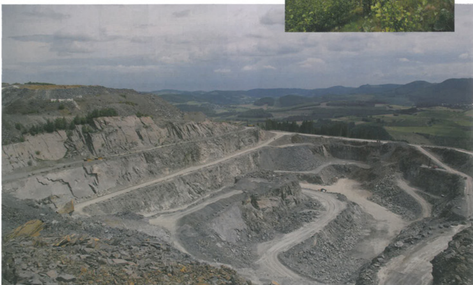
EINER DER GRÖSSTEN SEINER ART: Auf der linken Seite ist die Wiederanschüttung schon bis zur Wiederherstellung des Reliefs fortgeschritten und an vielen Stellen ist die Renaturierung bereits im vollen Gang. Fotos, soweit nicht anders angegeben: bwi
